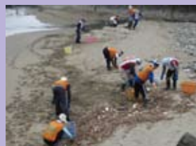
雄勝町の海岸復旧作業
