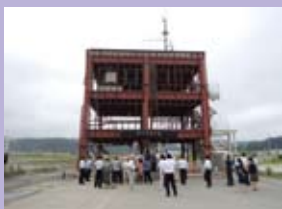
南三陸町防災対策庁舎
