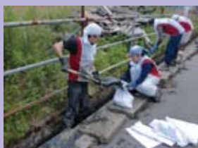
石巻市水明地区 側溝のヘド口除去作業
