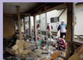
福島県いわき市瓦礫撤去 （東京）
