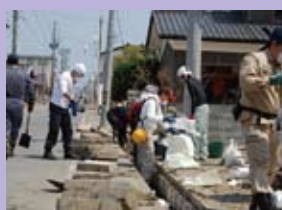
側溝の瓦礫・土砂除去作業 （兵庫）
